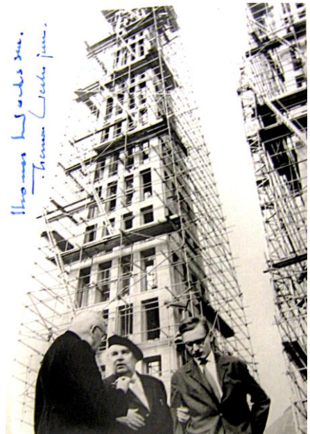
Pater Martin Söll SDB, erster Pfarrer von Don Bosco, mit den beiden Architekten Thomas Wechs sen. und Thomas Wechs jun. Vor den eingerüsteten Don Bosco-Türmen mit Unterschrift der Architekten.
